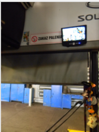
Montaż urządzeń - monitoring
