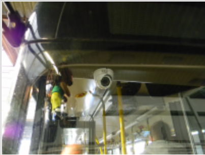
Montaż urządzeń - kamera
