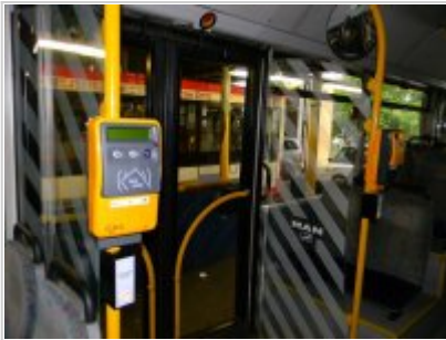
Montaż urządzeń - kasownik e-biletu
