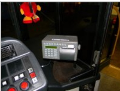
Montaż urządzeń - kasa fiskalna (biletarka)
