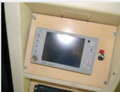
Montaż urządzeń w autobusach
