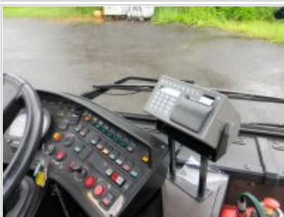
Montaż urządzeń - kasa fiskalna
