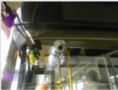
Montaż urządzeń - kamera
