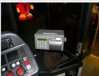
Montaż urządzeń - kasa fiskalna (biletarka)
