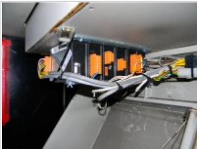
Montaż urządzeń w autobusach
