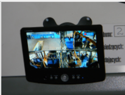
Montaż urządzeń - monitoring
